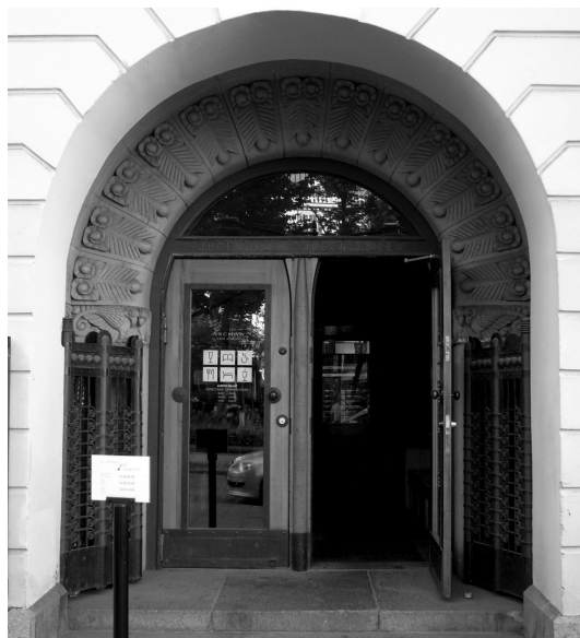
Рис. 5. Здание бывшего Приватбанка. Главный вход. Хельсинки, Северная Эспланада 19 — Юнионинкату 28, 1903–1904
