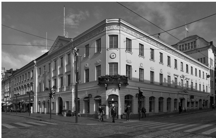
Рис. 3. Здание бывшего Приватбанка. Общий вид, Хельсинки, Северная Эспланада 19 — Юнионикату 28, 1903–1904
