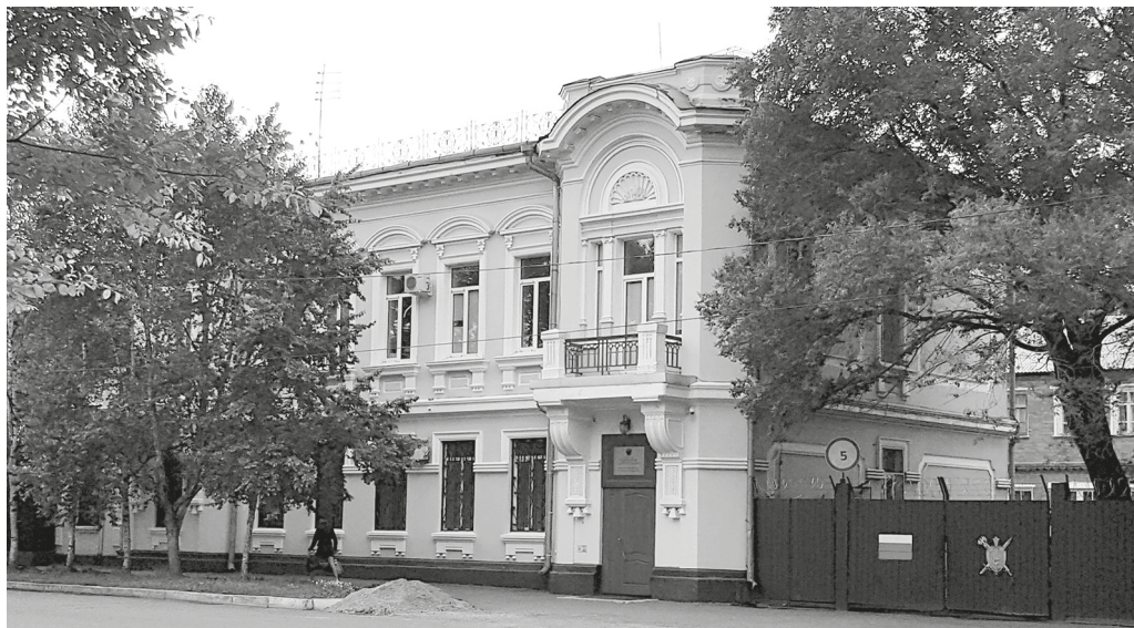
Рис. 19. Здание особняка-конторы П. Н. Кравецкого, арх. Д. В. Шебалин, 1914. Фото М. Е. Базилевича, 2021
