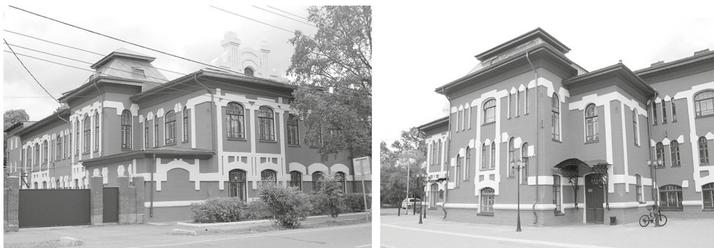
Рис. 17–18. Здание Народного дома, арх. Д. В. Шебалин, 1907–1908. Фото М. Е. Базилевича, 2021
