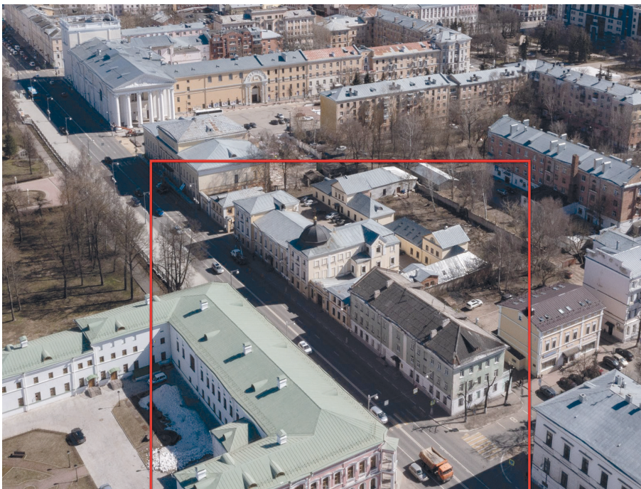
Рис. 2. Тверь. На снимке выделены дома № 5, 8 и 10 по улице Советской. Вид с северо-запада. Фото А. А. Ляникова, 2022
