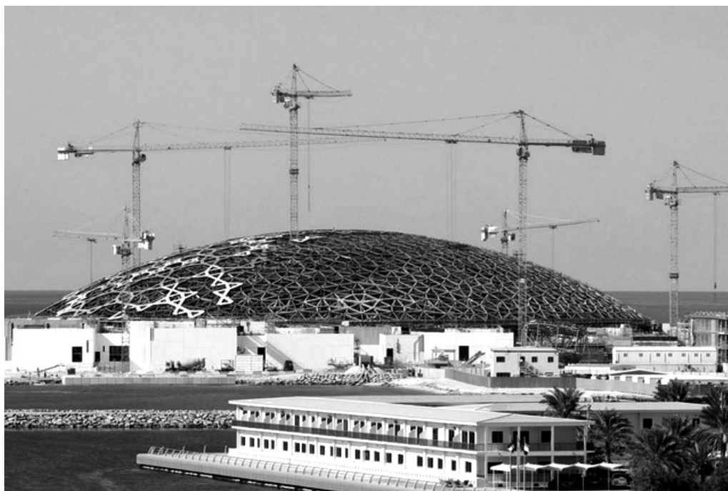
Рис. 6. Строительство музея Лувр Абу Даби, ОАЭ, арх. Ж. Нувель, 2015 г.
