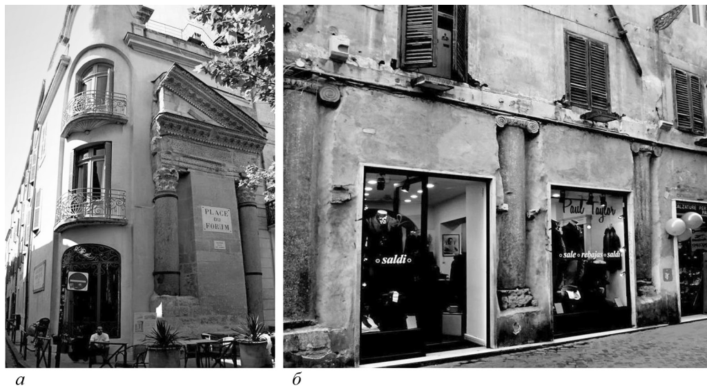
Рис. 2. Элементы древнеримских конструкций интегрированы в постройки позднего времени: а — в Арле, б — в Риме
