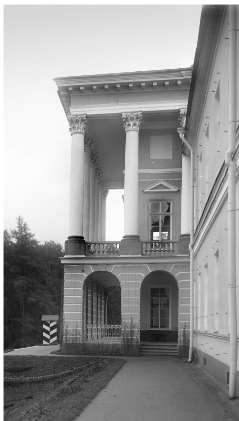
Рис. 5. Боковой вид парадного подъезда. Фотоархив ИИМК РАН
