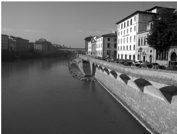
Рис. 6. Флоренция. Набережная Арно вблизи от Уфицци. Возрастающий транспортный поток вдоль реки в историческом центре вынудил реконструировать участок набережной вблизи моста Алле Грацие и произвести здесь расширение проезжей части.
