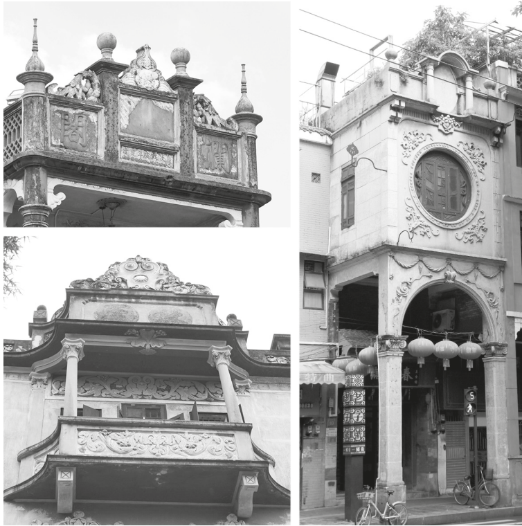
Рис. 3. Применение декоративных элементов: сверху слева — ци-лоу Хунлоу (红楼 / Hónglóu), г. Шэньчжэнь; снизу слева — лу Линьлу (林庐 / Línlú), деревня Мацзяньлун, городской округ Цзянмэнь; справа — ци-лоу, ул. Лунцзиньси (龙津西 / Lóngjīnxī), 83, г. Гуанчжоу. Фотографии авторов, 2018 г.
