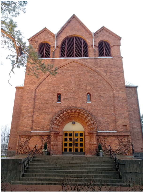
Рис. 10. Западный фасад. Фото В. В. Жердева
