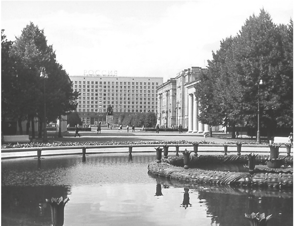
Рис. 28. Авторский коллектив под рук. Б. Н. Журавлева. Гостиница «Россия». Вид от пропилеев Московского парка Победы. 1962 г. Фотография 1980-х годов. Из личного архива В. Г. Лисовского
